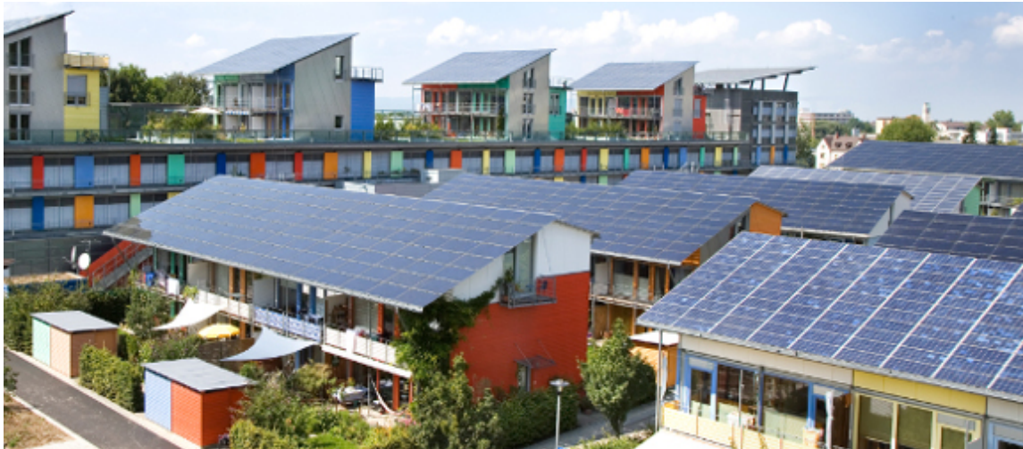
Solcellstak i Freiburg, Tyskland. CC BY-SA 3.0
