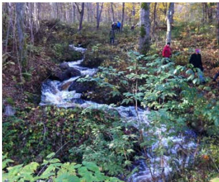
Omlöpet (fiskvägen) vid Kvarnekulla, Habo kommun, Jönköpings län, är med sina 570 meter ett av de längsta i Sverige. Här passerar bl.a. öring och flodnejonöga.
