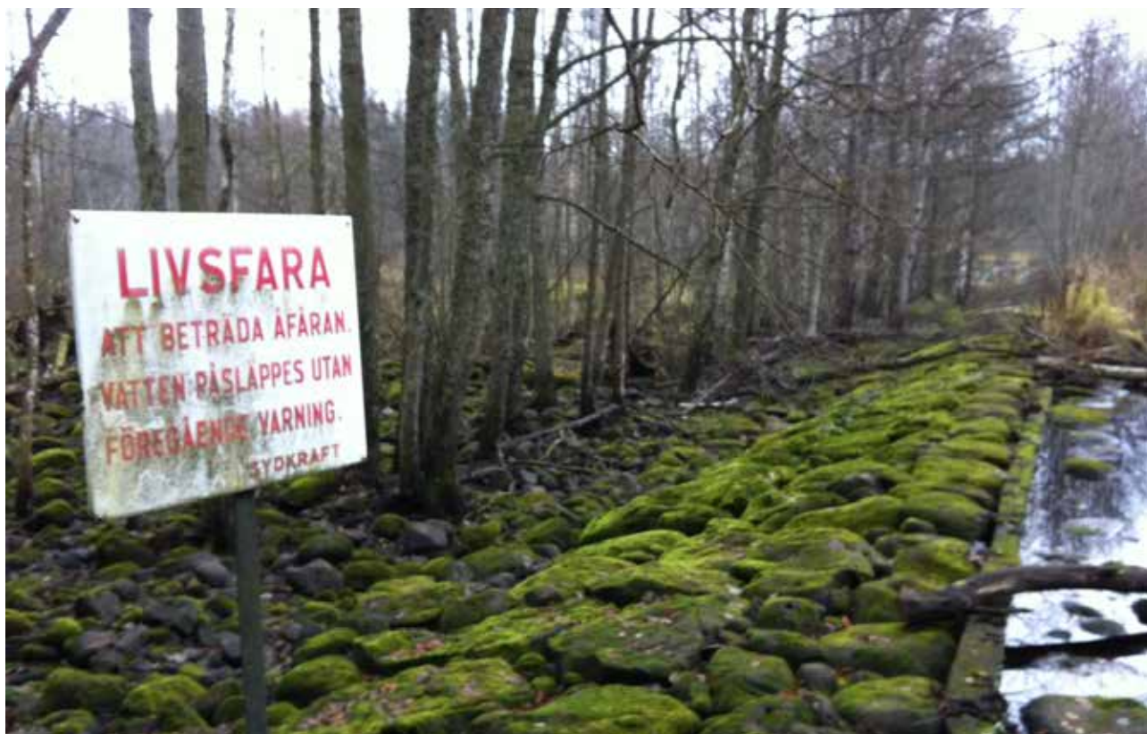
Huvudfåra i Mörrumsån. Vattnet som tidigare gick i huvudfåran avleds nu till Granö kraftverk. Från kraftverkets damm släpper verksamhetsutövaren en tappning till huvudfåran om 50 l/s.
