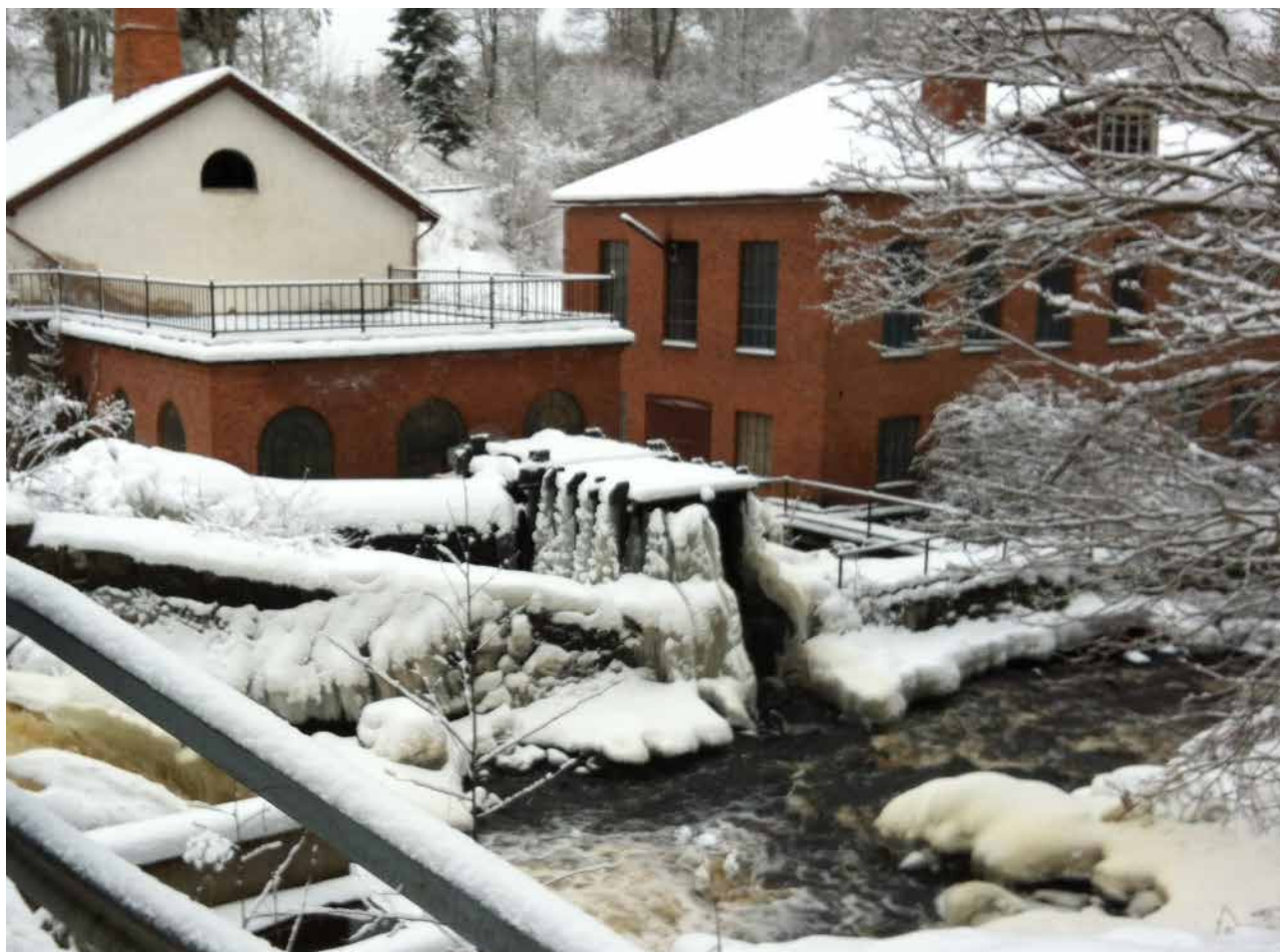
Ryfors övre kraftverk i Tidå, Mulsjö kommun, Jönköpings län.
