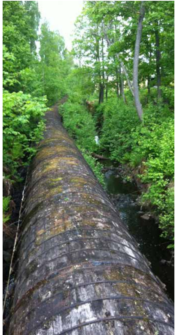
Tub som används för att avleda vatten från huvudvattenfåran till kraftverket.
